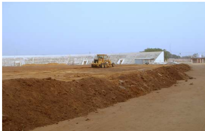
Les travaux d'installation d'un gazon artificiel homologué ont débuté à la mi-2006.
