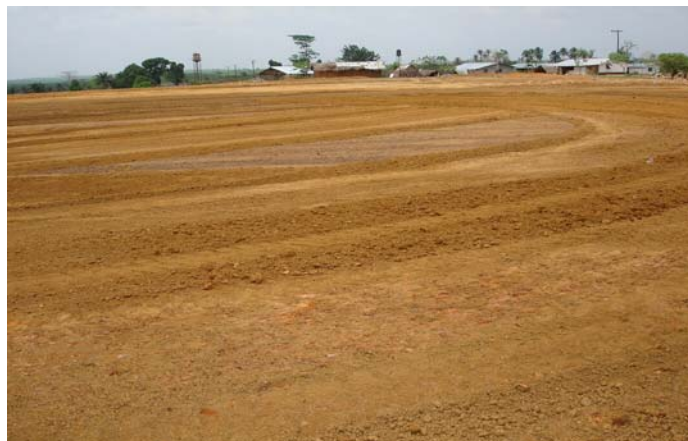
Préparation du terrain pour l'installation d'un gazon artificiel résistant à toutes les conditions climatiques.
